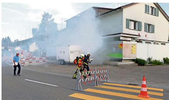
Die Feuerwehr übte am Abbruchobjekt in Ettenhausen, wo einst die Dorfläden wie der Denner-Satellit oder Seraina's Lädli Zuhause waren. Ab Montag wird abgerissen. kuli
